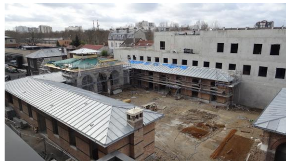
Le futur bâtiment Nocard, vue prise du bât. Guérin. Les toitures des anciens bâtiments sont terminées et les nouvelles constructions, gros œuvre terminé, sont « hors d'eau »
