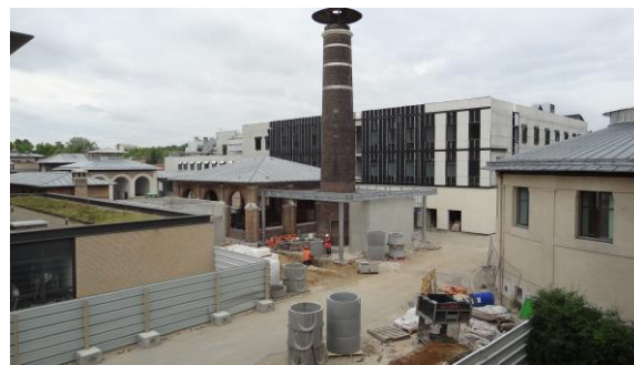
Le futur bâtiment Nocard, vue prise de la bibliothèque. La cheminée sécurisée porte des cercles de fer avec le nom « Amphithéâtre Nocard », l'ancien crématoire agrandi 03 juin 2019 © JP Mialot
