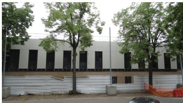
Le futur bâtiment Chauveau ; vue prise du bât. Letard. 03 juin 2019 © JP Mialot
